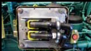
Der **Electronic Speed Governor** sorgt für eine konstante und **stabile Motordrehzahl** und **Generatorfrequenz**. Zusammen mit dem AVR resultiert dieses in eine bessere Leistung für sensible Belastungen. Sowohl E.S.G. wie auch AVR sind unentbehrlich bei **Parallelbetrieb** verschiedener Stromerzeuger.
